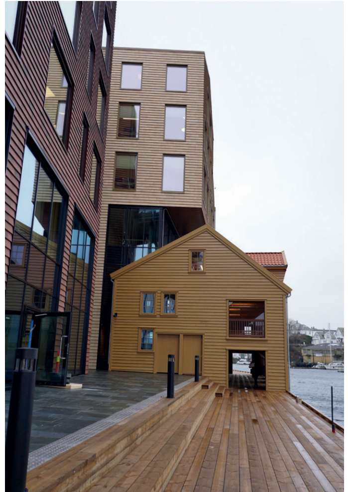
En ny promenade med tredekke er lagt oppå den nye kailinjen i betong. Promenaden går gjennom det nye sjøhuset i gammel stil.
