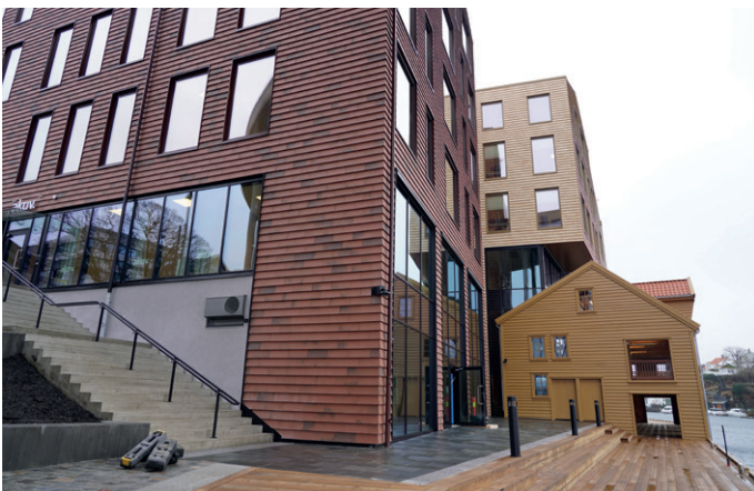
En ny promenade med tredekke er lagt oppå den nye kailinjen i betonging. Promenaden går gjennom det nye sjøhuset i gammel stil.
