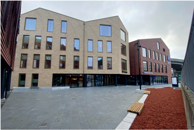
En åpen plass med blomsterbed og sitteplasser er anlagt på østsiden av bygget. Bedet er før planting dekket med knust takstein fra et bygg som måtte rives.
